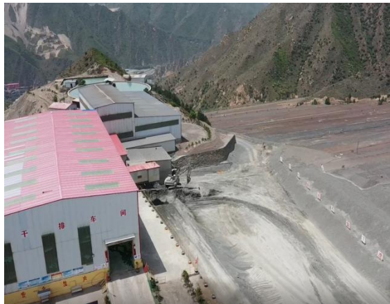
干排车间及小地沟尾矿库
