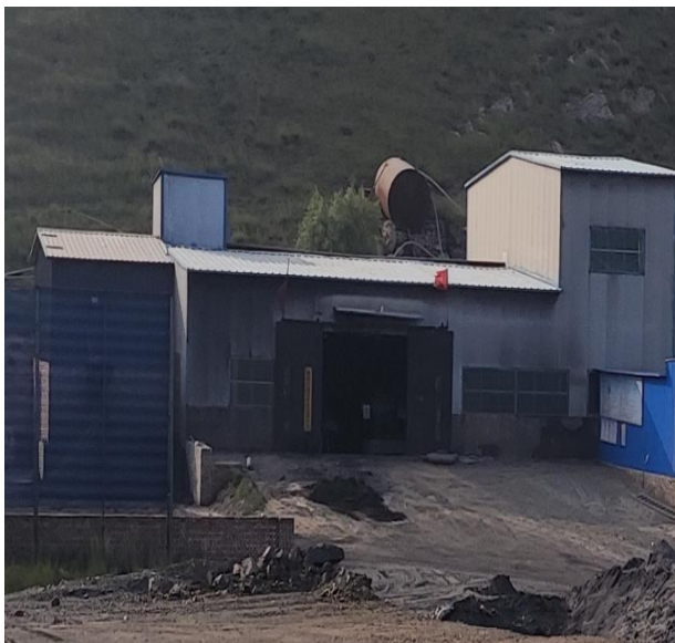
现有工程选矿车间
